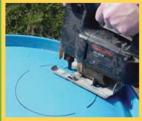
Corte del orificio superior
